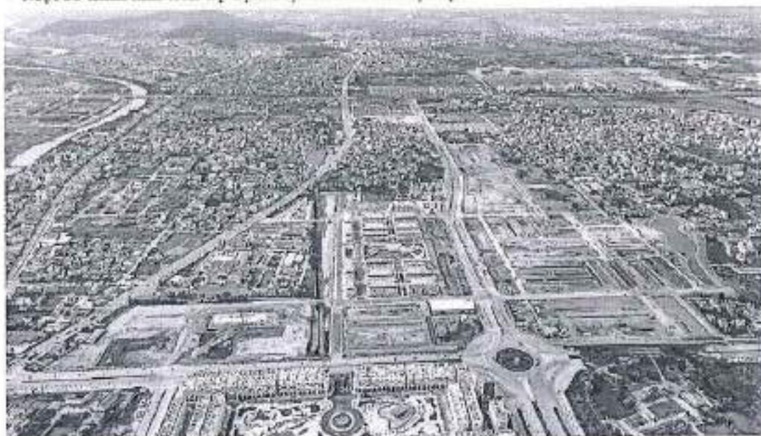
Toàn cảnh dự án đang triển khai thi công
