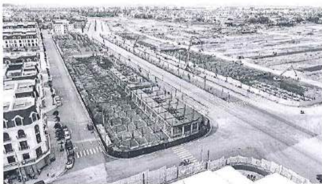
Một góc dự án đang triển khai thi công hạ tầng nội khu, xây dựng một số khu nhà ở liền kề tại thời điểm tháng 6 năm 2025.
